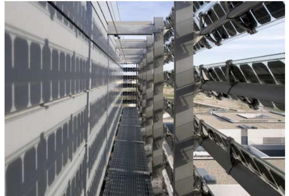
Fachada de arcos fotovoltaicos de generación de energía eléctrica
